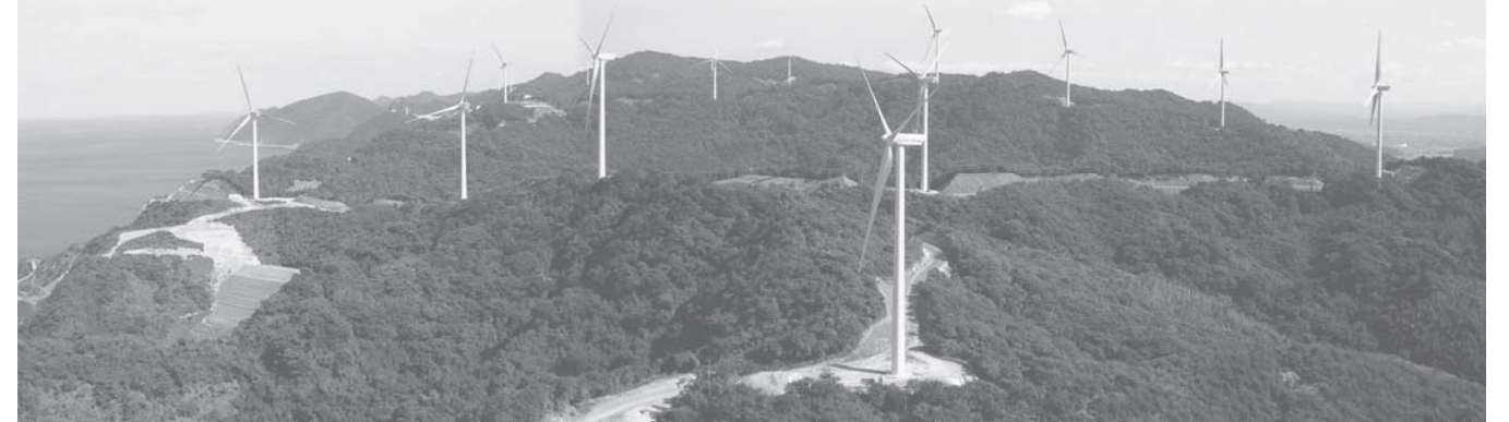
4月1日に本格稼働した新出雲風力発電所
