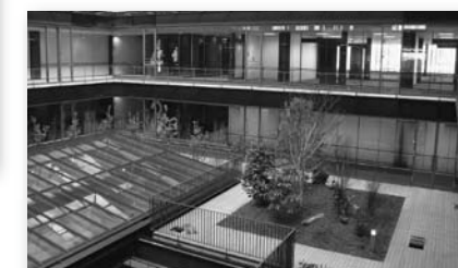
自然の光や風を有効利用するため、中央に吹き抜けを設けています
