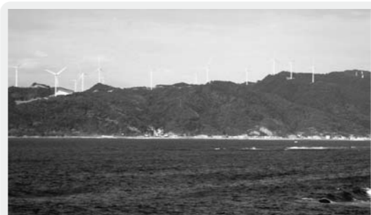
工事が着々と進められている風力発電施設
