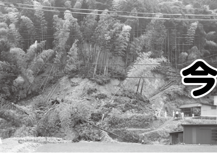
大雨による土砂災害の様子(平成19年7月15日から16日にかけての大雨 所原町)
