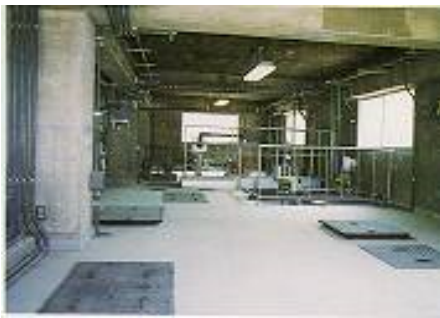
▲ ろ過・吸着設備
