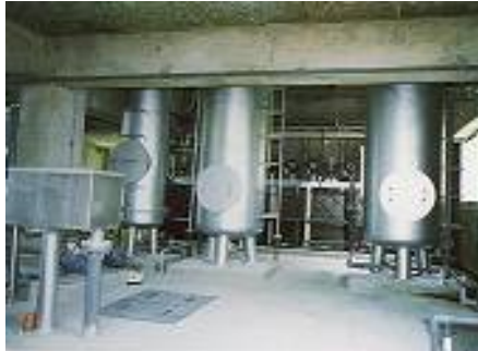
▲ 生物処理及び凝集沈殿処理装置
