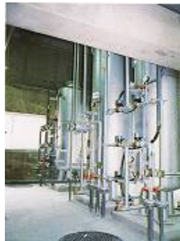
▲ ろ過・吸着塔
