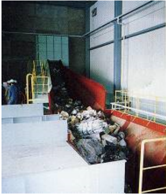
↑ 受入ホツパ及び供給コンベヤ
