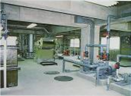
▲ 汚泥脱水機及び各種器機類
