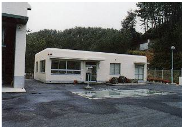
↑ 管理棟と計量器(トラックスケール)
