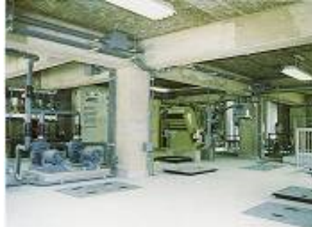
▲ 浸出液処理装置
