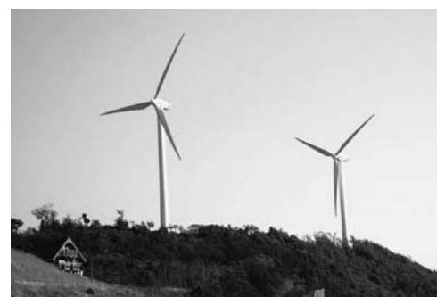
キララトゥーリマキ風力発電施設
