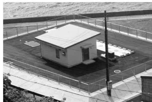
平成19年3月には漁業集落排水処理施設「釜浦地区処理センター」が完成
