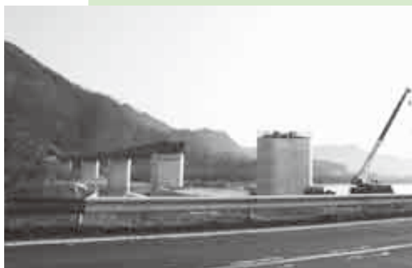
山陰自動車道の斐伊川橋梁上部工事も着々と進んでいます（2月22日撮影 上島町）
