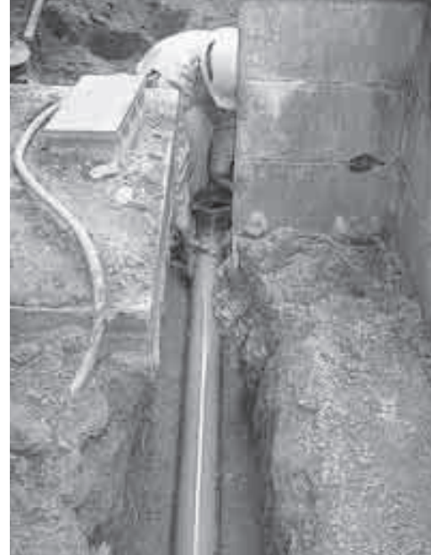
宅内排水設備工事の様子
