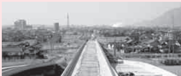
着々と工事が進む国道9号出雲バイパス(大津高架橋から西方向を臨む 2月24日撮影)
