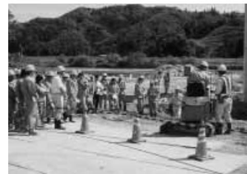
工事現場を見学する出雲農林高校の生徒。ショベルカーの運転なども体験しました(5月17日)
