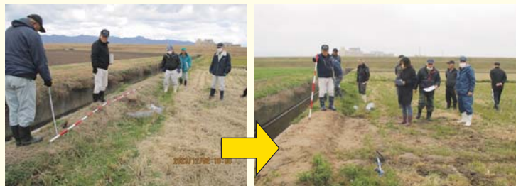
事前調査 (井上用水路修繕工事)
