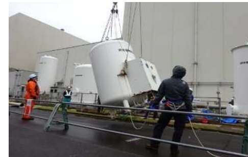
撤去作業の状況
