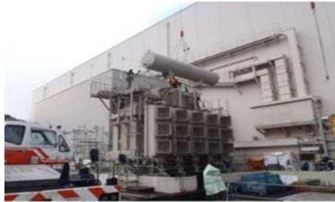
撤去作業の状況
