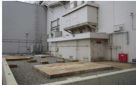
撤去作業後の状況
