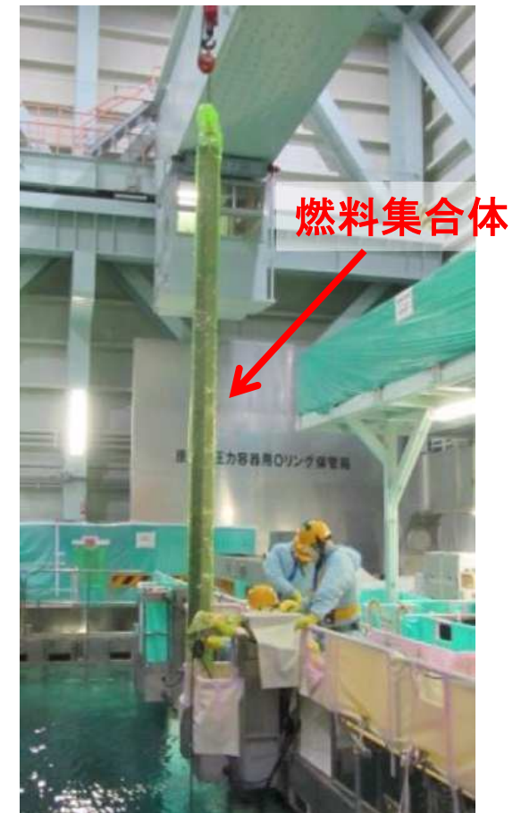
新燃料の引き上げ状況
