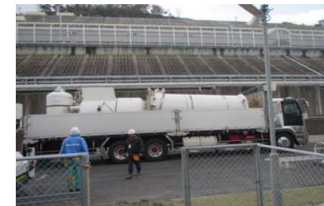
解体物の移送
