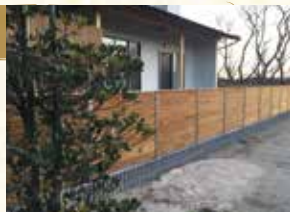
フェンスの施工例
