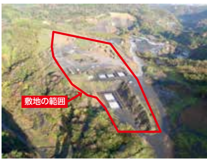
【沈砂池設置後の敷地の様子】
