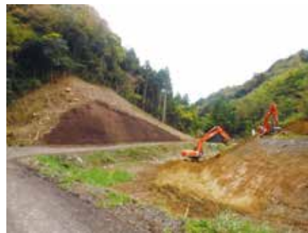
【法面工事の様子】
