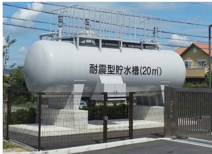
耐震性緊急貯水槽
