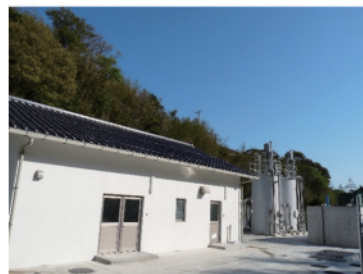
日御碕浄水場
