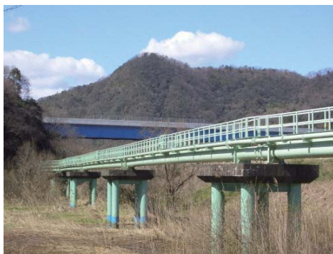
岩棚池水管橋（導水管）
