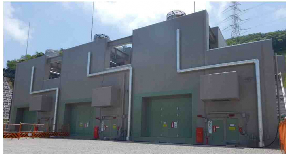
建物工事状況(平成30年5月14日撮影)
