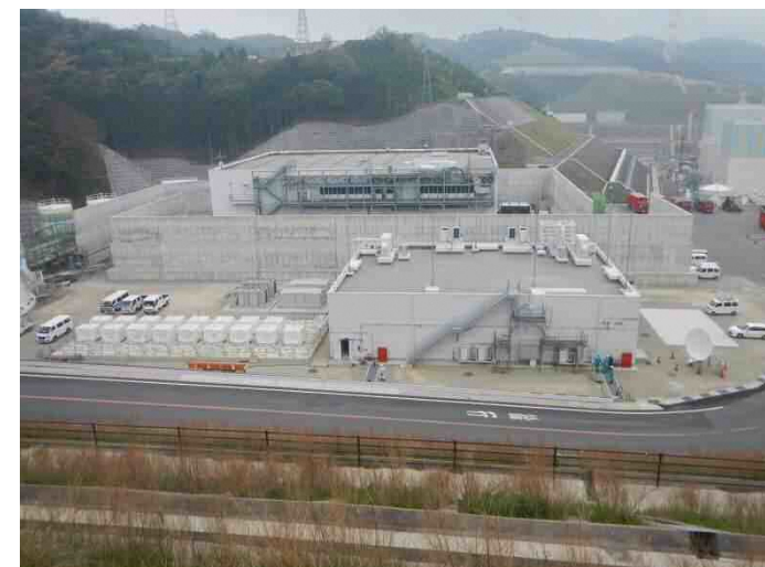
工事状況(平成30年4月23日撮影)
