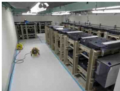
蓄電池 (追加設置)
