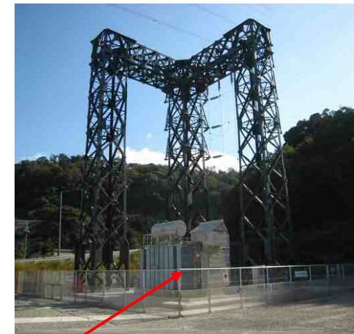
66kV受電設備
