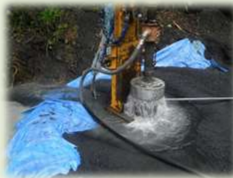
写真：試験井戸掘削中の様子
