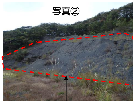
腹付け盛土 (改良材による固化)
