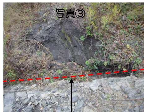
腹付け盛土と地山(岩盤) 境界に段差、空隙あり
