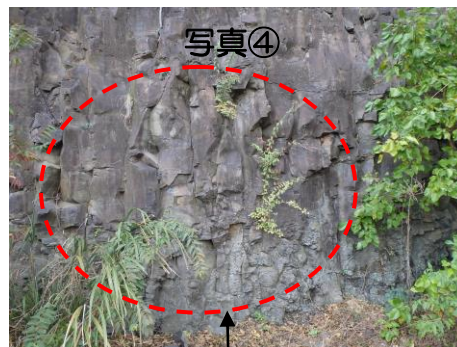
切土斜面は硬質な岩盤(中 硬岩から硬岩程度)
