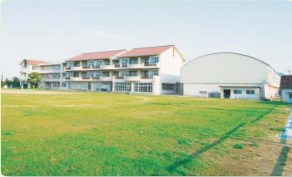
大津小学校全景
