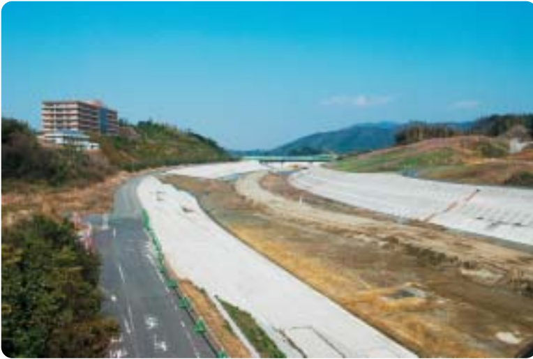
斐伊川放水路
