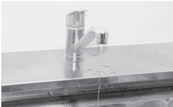
生活に欠かせない水道
