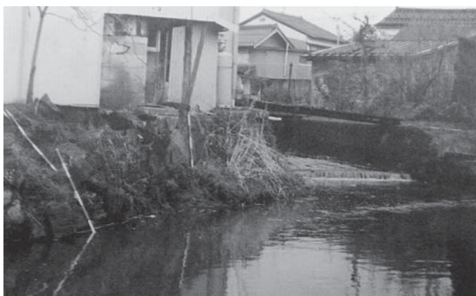
放置されてきた湯谷川中町界隈の現状
