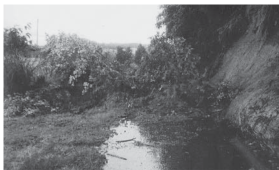
7月豪雨災害での道路被害
