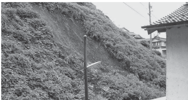
急傾斜地の崩落（小伊津町）
