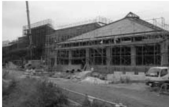
建設中のタラソテラピー
