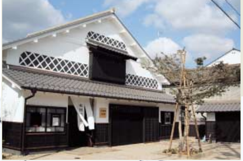
10月1日に竣工した出雲市立木綿街道交流館
