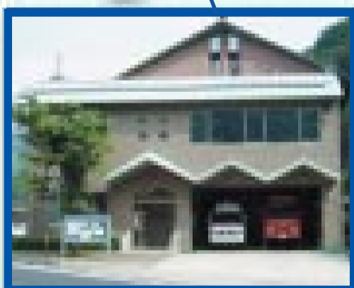
出雲消防署南部分署（佐田町大字反辺） 【出雲市外4町広域消防組合】
